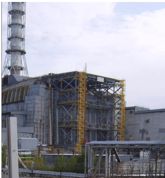
Konstrukcja wzmacniająca dach nad sarkofagiem (przed jego rozbiórką).
